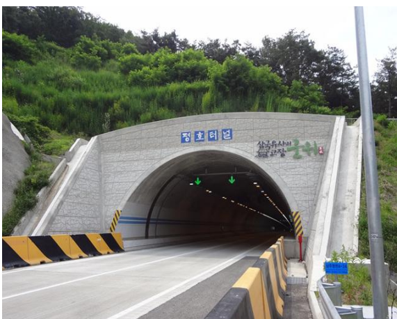
4공구 평호터널(영천방향) 시점부
