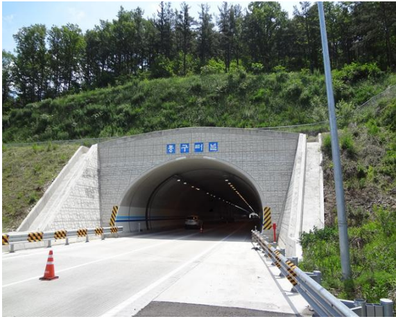
5공구 중구터널(영천방향) 시점부
