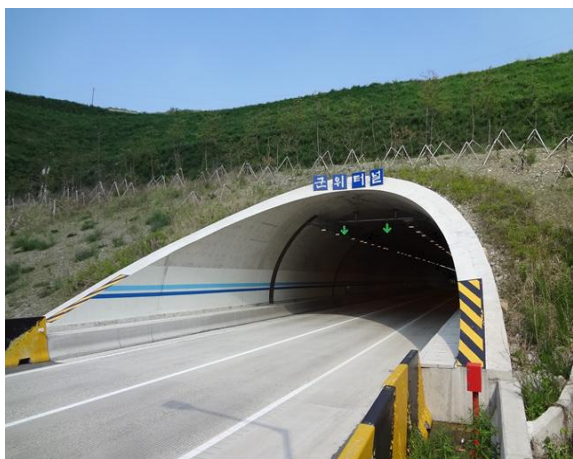
3공구 군위터널(영천방향) 시점부
