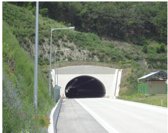
5공구 불로터널(영천방향) 종점부
