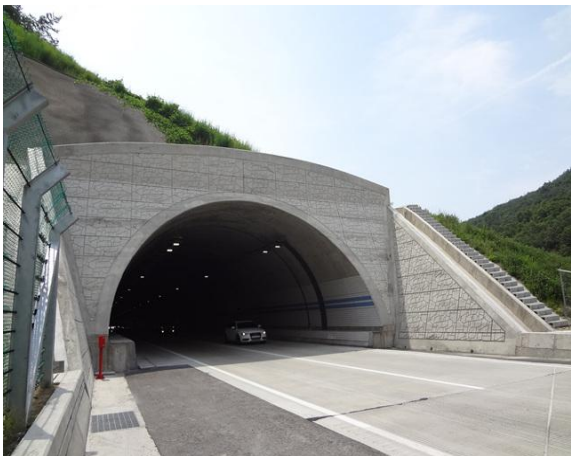
4공구 평호터널(상주방향) 시점부
