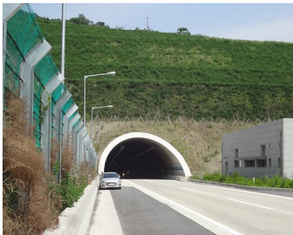
3공구 군위터널(상주방향) 시점부
