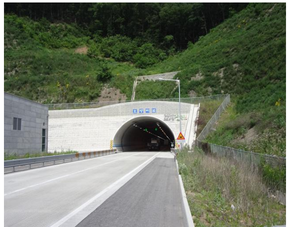
5공구 효령터널(상주방향) 종점부
