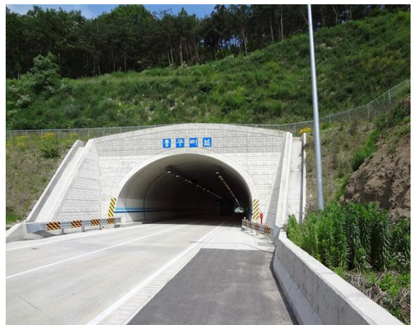
5공구 중구터널(상주방향) 종점부
