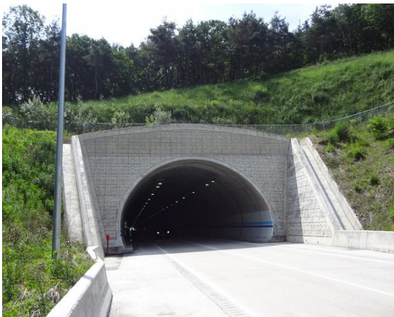
5공구 효령터널(상주방향) 시점부
