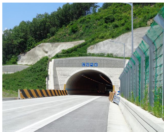
4공구 산법터널(상주방향) 종점부
