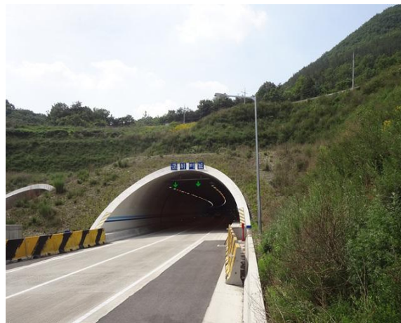
3공구 군위터널(상주방향) 종점부
