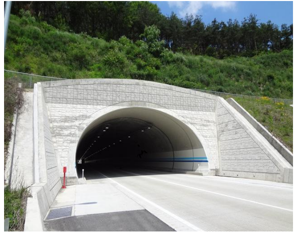
5공구 중구터널(영천방향) 종점부
