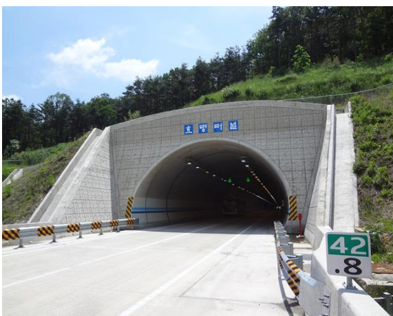
5공구 효령터널(영천방향) 시점부
