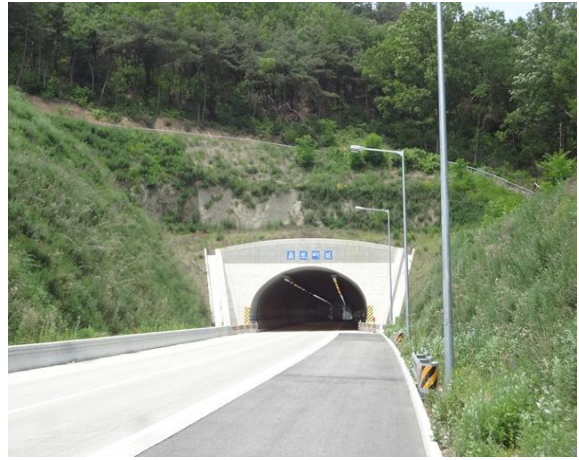
5공구 불로터널(상주방향) 종점부
