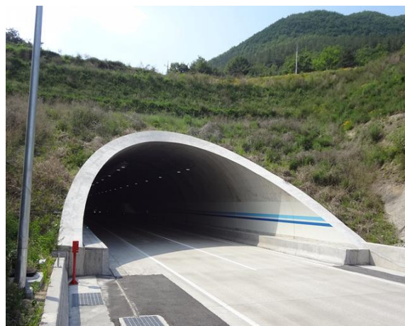
3공구 군위터널(영천방향) 종점부
