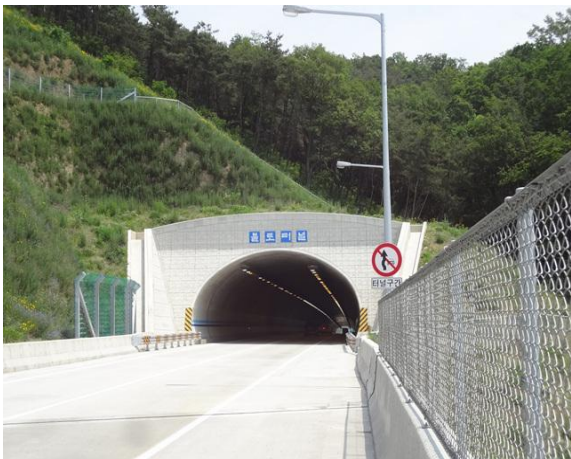
5공구 불로터널(영천방향) 시점부
