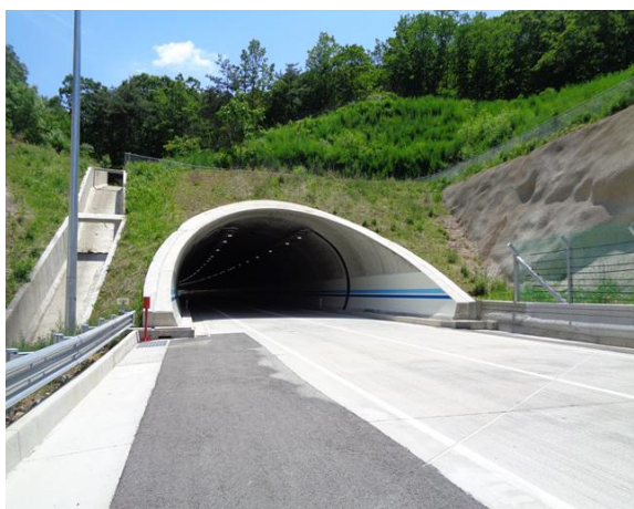
4공구 산법터널(상주방향) 시점부
