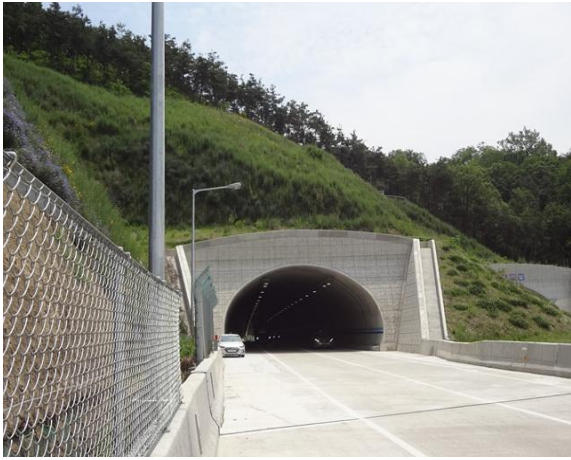
5공구 불로터널(상주방향) 시점부
