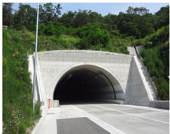
4공구 평호터널(영천방향) 종점부
