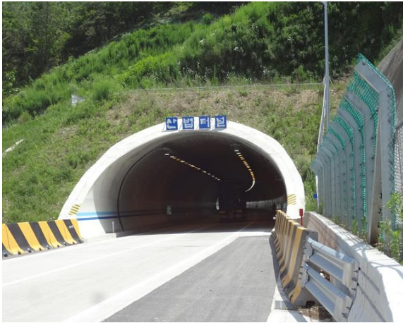
4공구 산법터널(영천방향) 시점부
