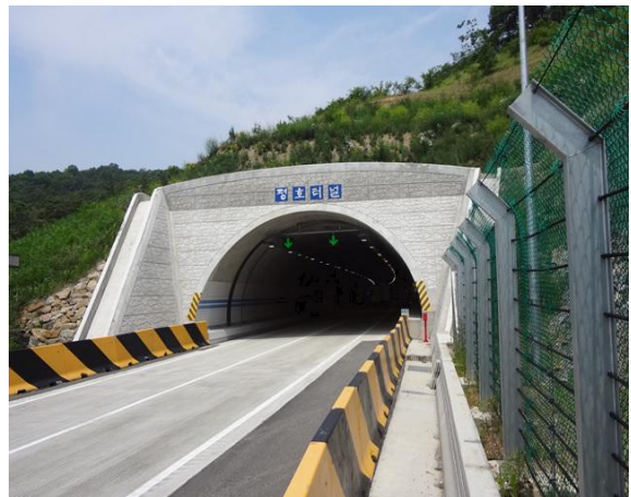
4공구 평호터널(상주방향) 종점부
