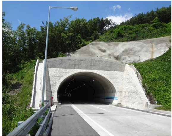
4공구 산법터널(영천방향) 종점부
