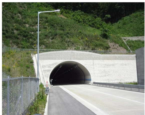
5공구 효령터널(영천방향) 종점부
